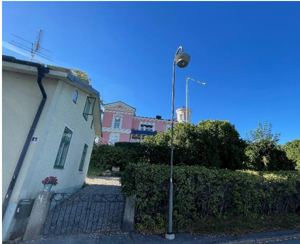
Nivåskillnader mellan byggnaden längs med Östra Strandvägen och huvudbyggnaden på Hörngården 2 som ligger längs med Vasagatan. Källa: Samhällsbyggnadskontoret
