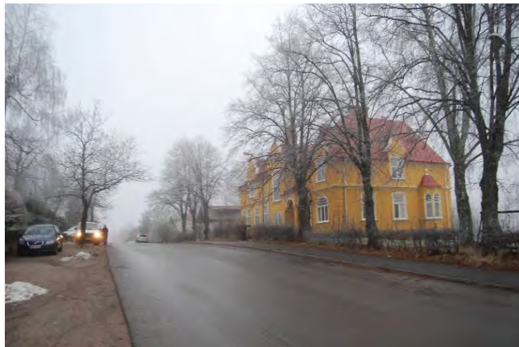
Byggnadsminnet Wickmans villa, Kv Jägmästaren 4, vid Nygatan
