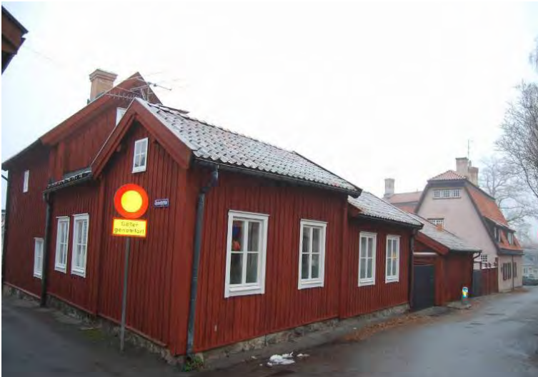
Rödfärgade hus i nätt skala vid Glasbergsgård, kv Glasberget 7
