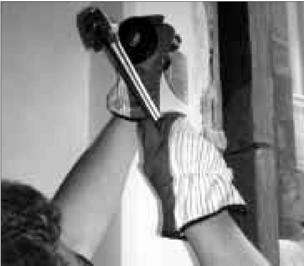
Figur 27. Fogen tas bort med hjälp av stämjärn.
