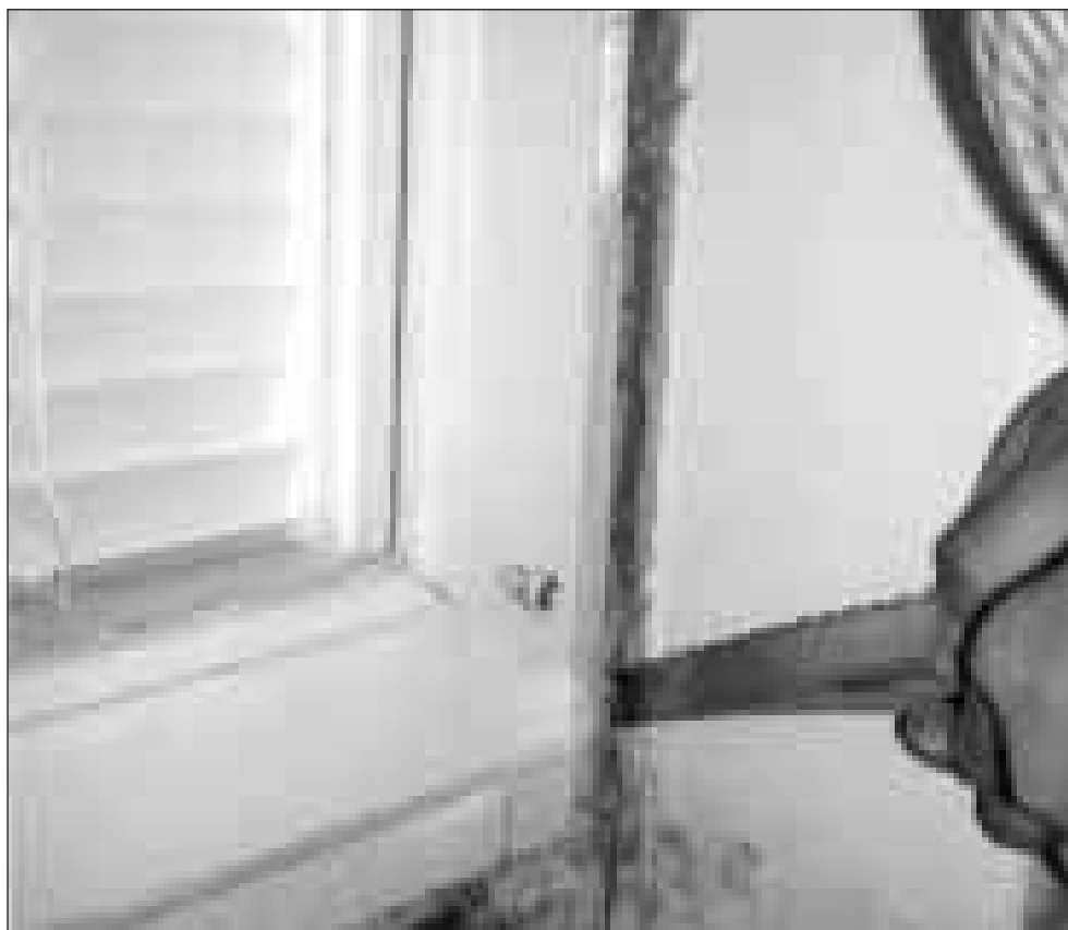
Figur 26. Fogmassa skärs ut med vanlig kökskniv från insidan av ett fönster.
