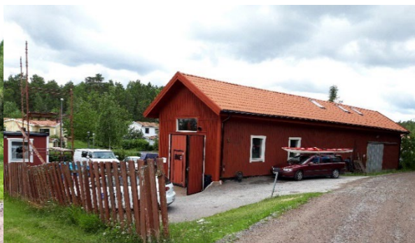
Bild 2 Byggnad som används för verkstad på fastigheten Slottsbrinken 1:49. Källa: Samhällsbyggnadskontoret
