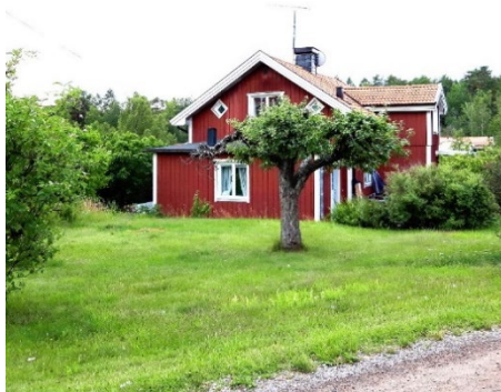
Bild 1 Befintligt bostadshus på fastigheten Slottsbrinken 1:49. Källa: Samhällsbyggnadskontoret
