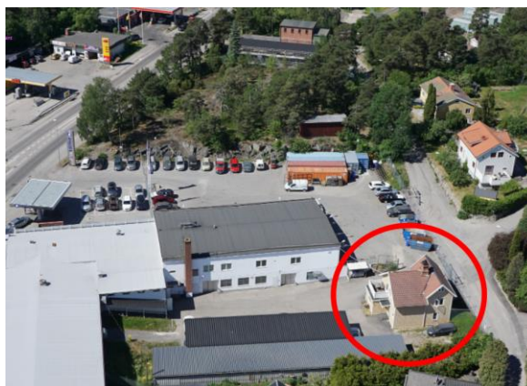
Drönarfoto(Strängnäs kommun) över fastigheten Erikslund 11. Bilverkstan, skärmtaket och träbyggnaden i Nordöst(Röd markering).
