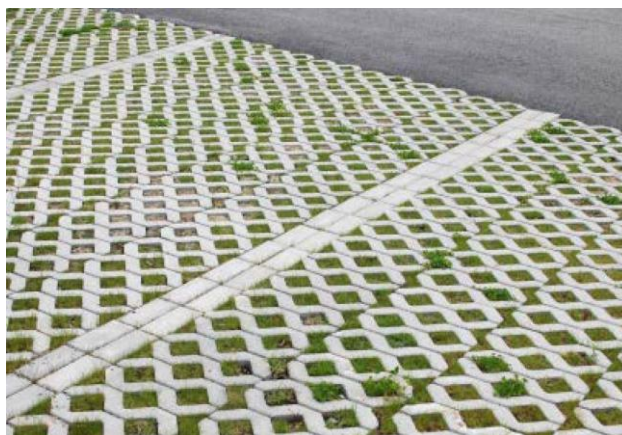
Hålsten/betongraster med gräs på parkering i Växjö. Foto: Sweco.
