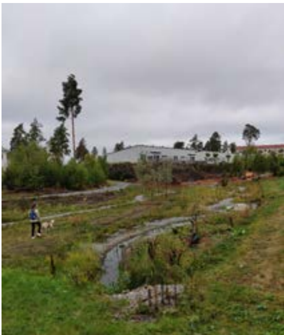
Foto 2. Dagvattenlösning vid det nya bostadsområdet Stavlund Bresshammar på Tosterö. Anläggningen är byggd i anslutning till en lekplats vilket uppmuntrar till vattenlek vid måttlig nederbörd och förhindrar översvämning vid skyfall. Fotat av: Charlotta Rasmusson
