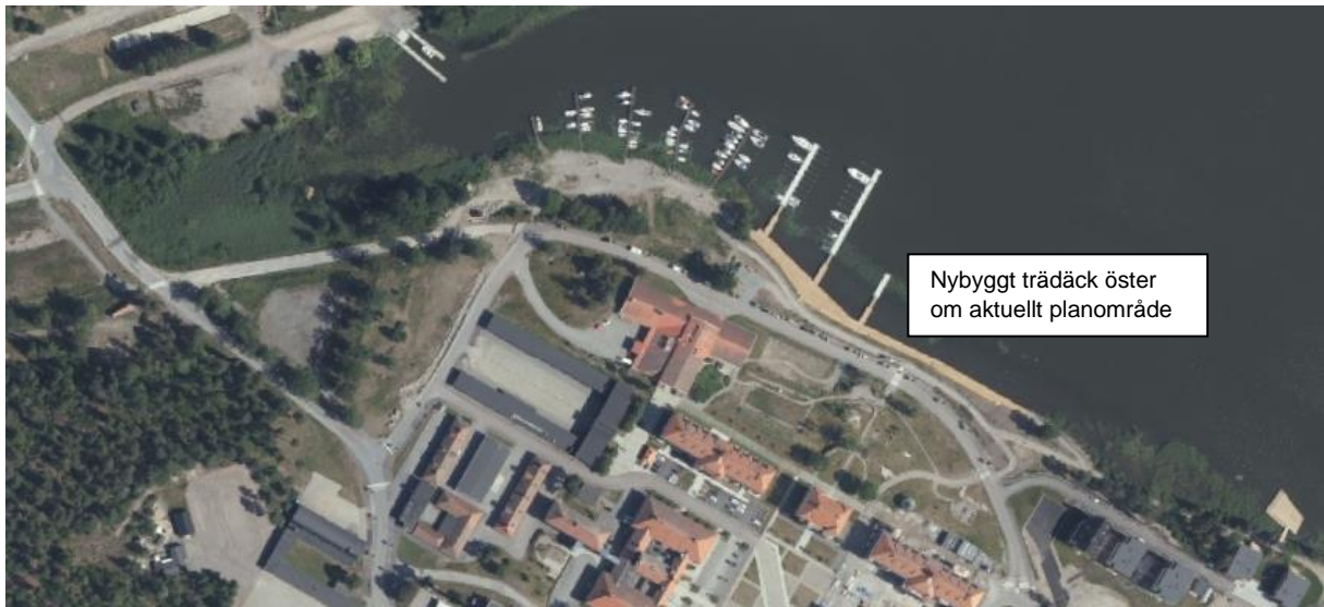
Figur 6.24. Översikt över nybyggt trädäck med båtplatser och badbrygga. Bildkälla: Ortofoto från Strängnäs kommun, bearbetat av Norconsult.
