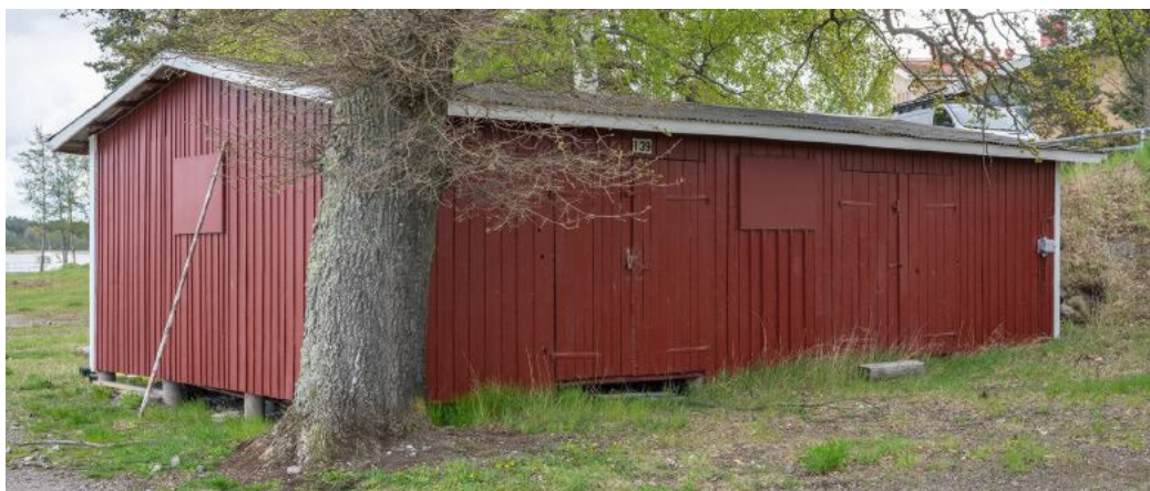
Byggnad 133 uppförd 1941. Används som kallförråd för båtklubben. Källa: Sörmlands museum, 2020-05-28, Fördjupad kulturmiljöanalys av motorområden vid f.d. P 10
