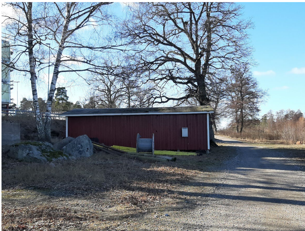
Byggnad 133. Källa: Strängnäs kommun
