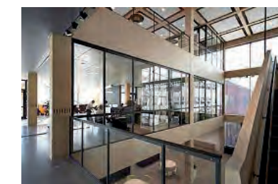
Limträ i entrébyggnaden
